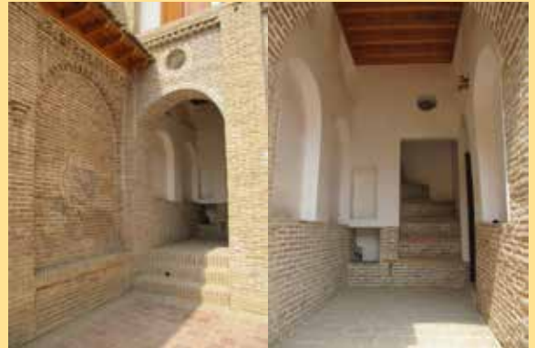
شکل (۱۱ و ۱۲) پلکان ساختمان جنوبی
